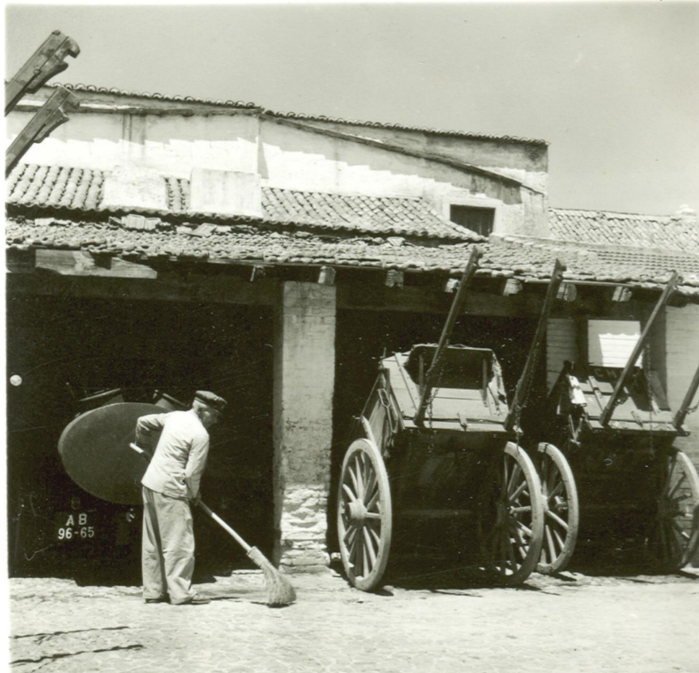
Fig. 4 O pátio da Igreja de S. Francisco a funcionar já como Abegoaria Municipal, com os antigos carros de recolha de dejectos debaixo do telheiro. Observam-se as chaminés e parede Sul da sacristia.
