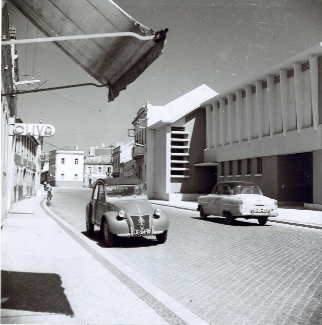
Fig. 11 ó O local da Igreja de S. Francisco depois da sua demolição e já com a Estação Telefónica Automática do Barreiro em funcionamento.
