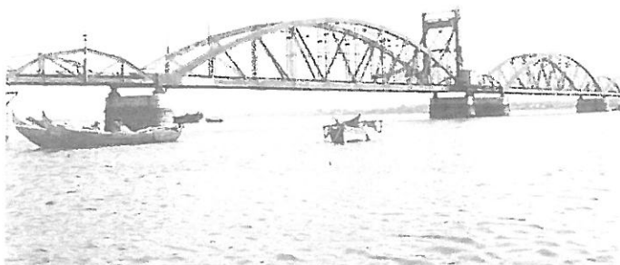
A ponte ferroviária sobre o rio Coina, que ligava o Barreiro ao Seixal em 1950. Fonte: Arquivo Municipal do Barreiro.
