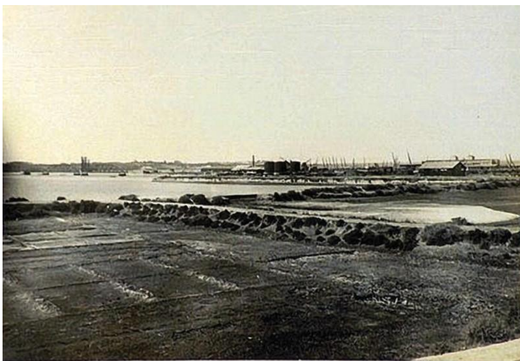
BARREIRO — Criosotagem dos Caminhos de Ferro - Salinas
